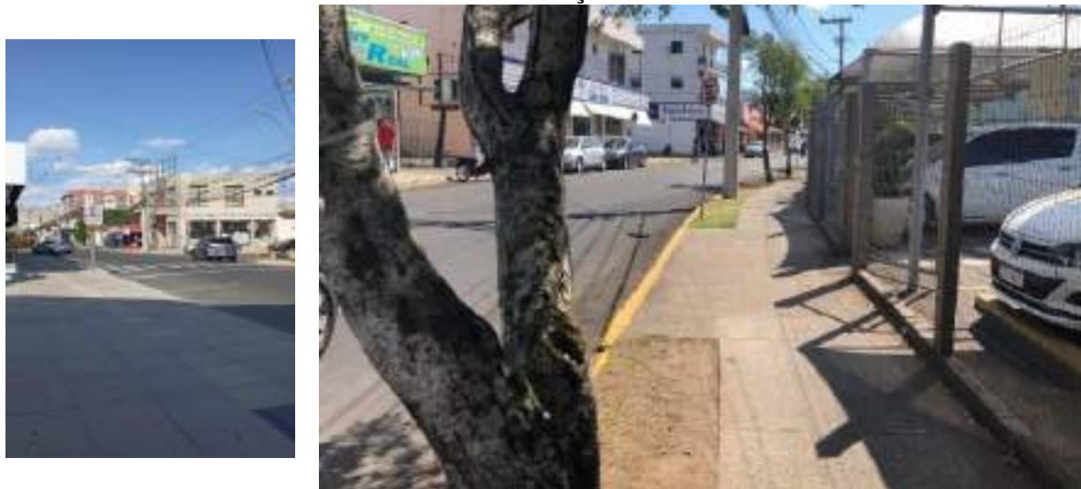
Figura 70 – Exemplo de imagens do levantamento de calçadas do município em bom estado de conservação.
