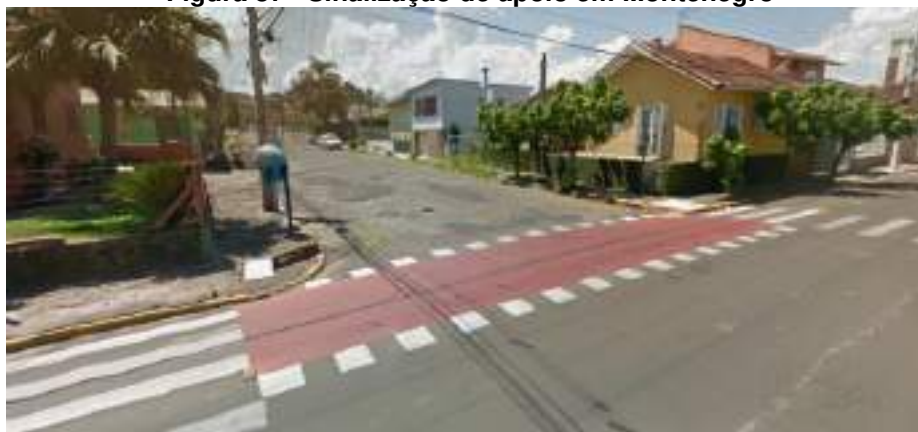
Figura 87– Sinalização de apoio em Montenegro
