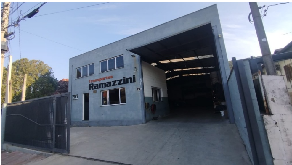
Imagem: Fachada prédio existente
