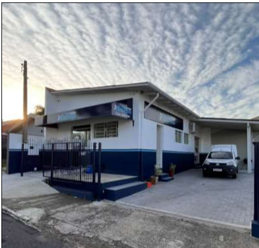
Figura 2: Imagem da Fachada do Empreendimento
