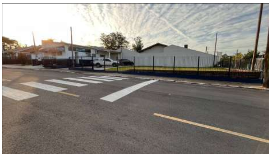
Figura 3: Imagem da Fachada do Empreendimento
